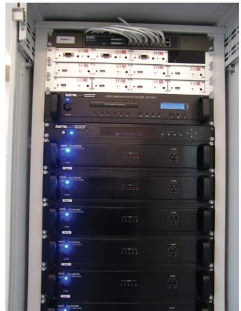
Vista frontal dos descodificadores Exstreamer da Barix (em cima), mostrando o material de distribuição de áudio via IP e o de amplificação, contendo internamente módulos de supervisão
